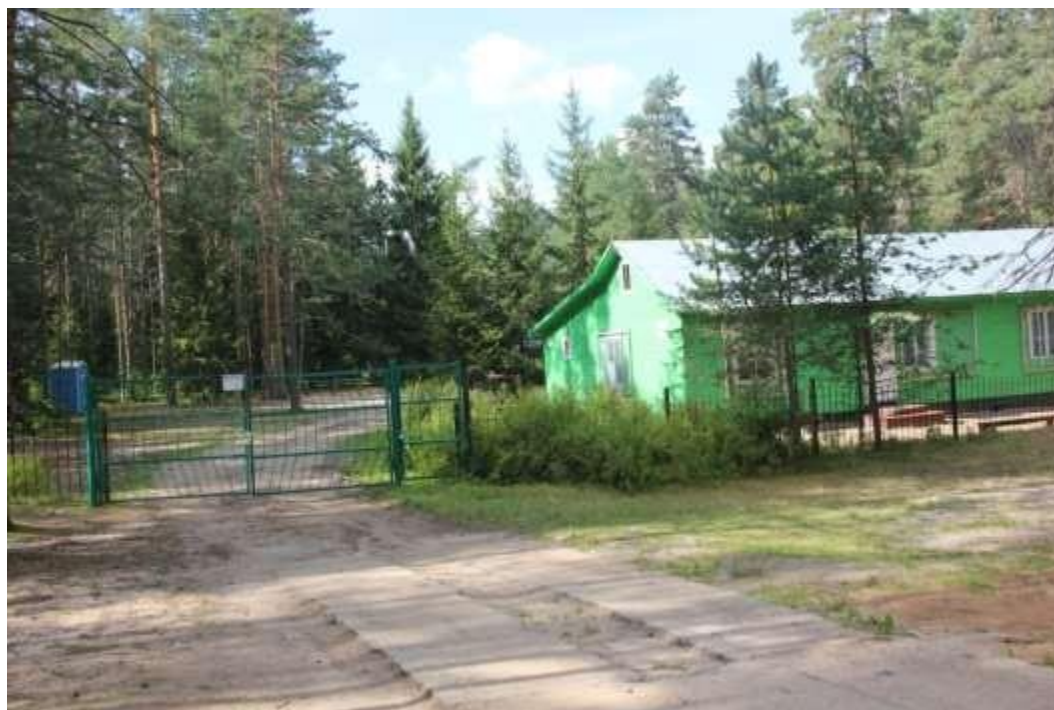
Фото 2. Центральный въезд в лагерь
