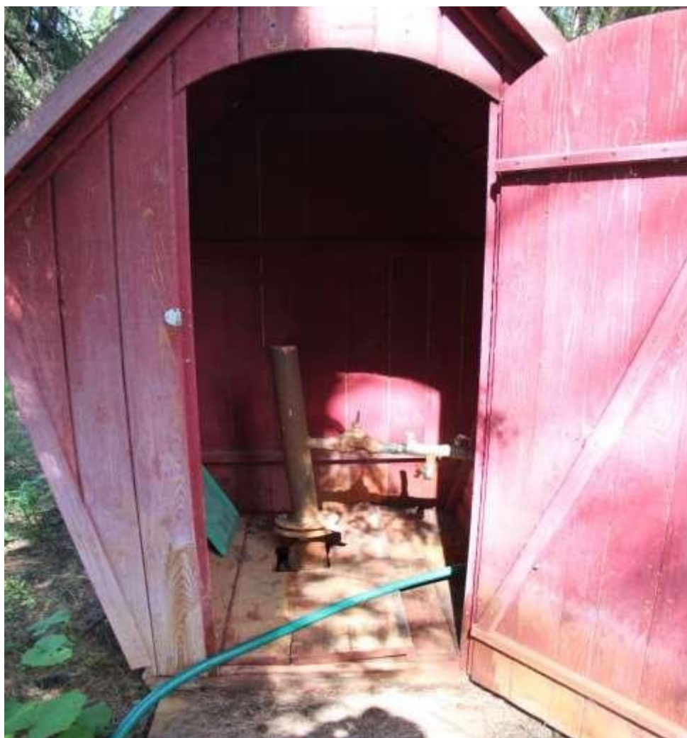
Фото 5. Действующая скважина внутри домика
